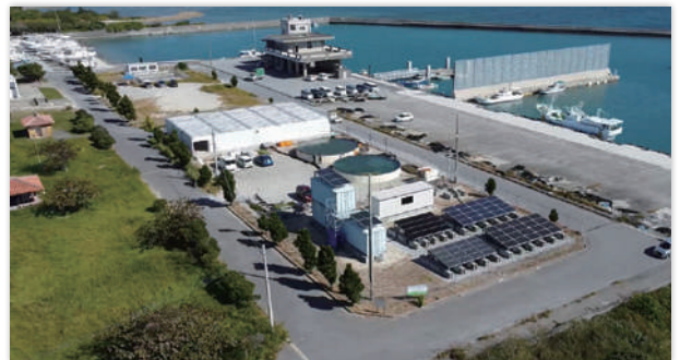
ヤイトハタの閉鎖循環型陸上養殖システムの研究を行う養殖施設。再生可能エネルギー施設も隣接する。(オリオンビール株式会社提供)
