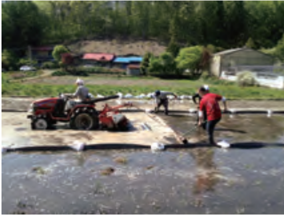
までい工法施工の様子
