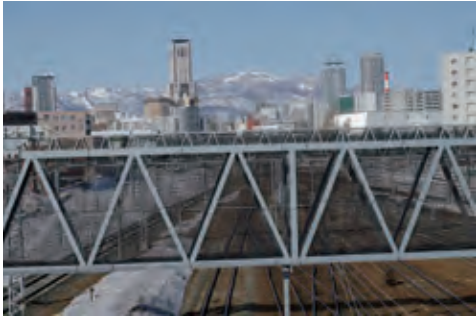
トラス桁橋の骨組み
